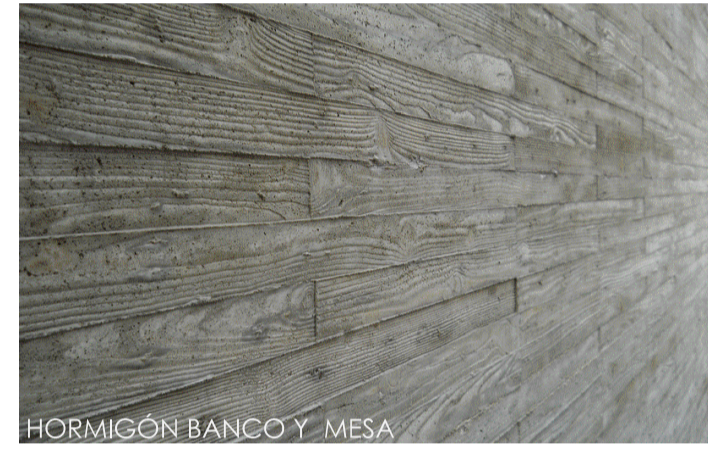
HORMIGÓN BANCOS Y MESA
